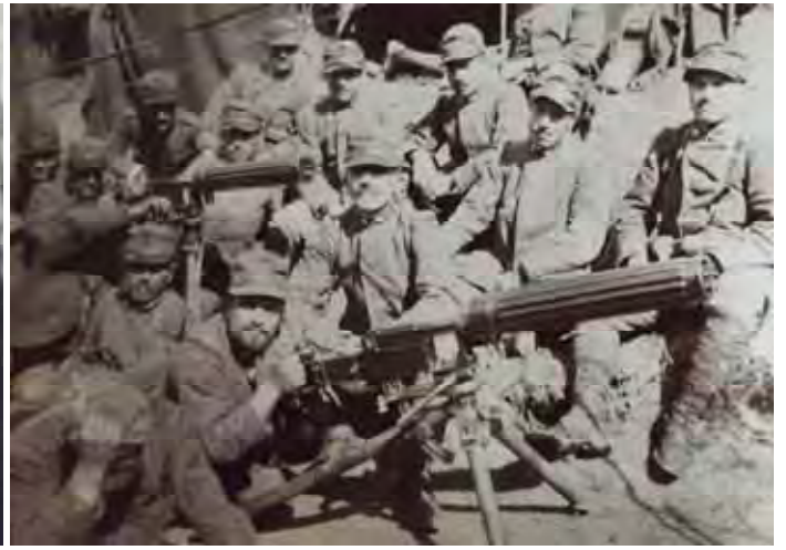
Gruppo di mitraglieri FIAT. La mitragliatrice FIAT-Revelli mod 1914 (rigata), cal 6,5mm era raffreddata ad acqua e munita di un oliatore continuo per lubrificare le cartucce. Peso: 17 kg Cadenza: 400c/min; portata 1500m circa
