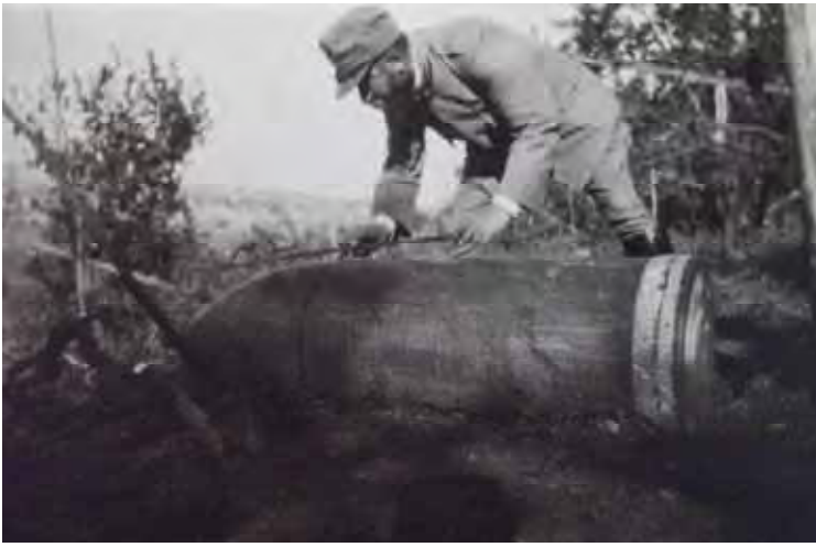
Misurazione di un proiettile di mortaio da 30.5 austriaco inesploso. Pesava circa 400 kg con una gittata di circa 15 km ed una cadenza di tiro di qualche colpo al minuto. Notare la doppia corone di forzamento all'estremità.
