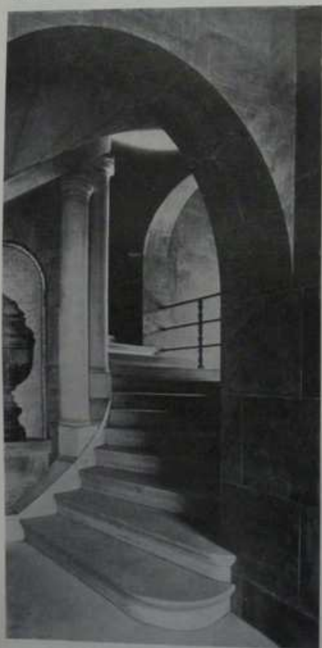
Ingresso della scala elicoidale
